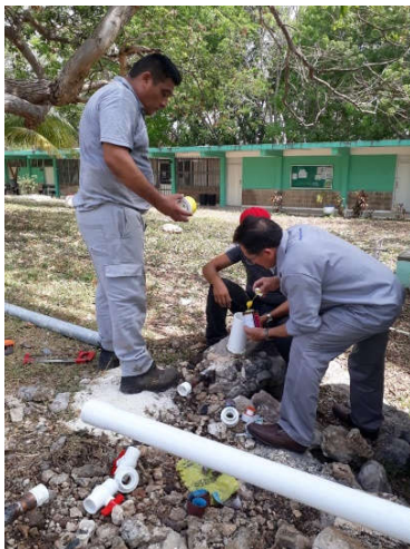
Cambio de tubería a bajante de tanque elevado y ramales de distribución de agua potable.
