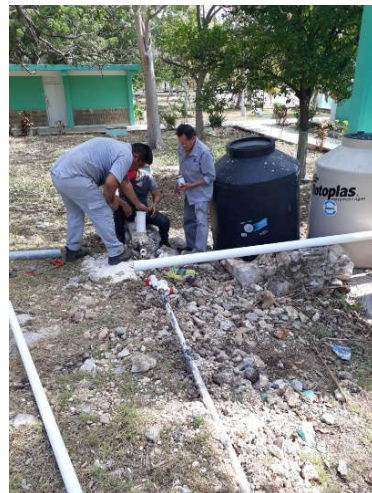
Cambio de tubería a bajante de tanque elevado y ramales de distribución de agua potable.
